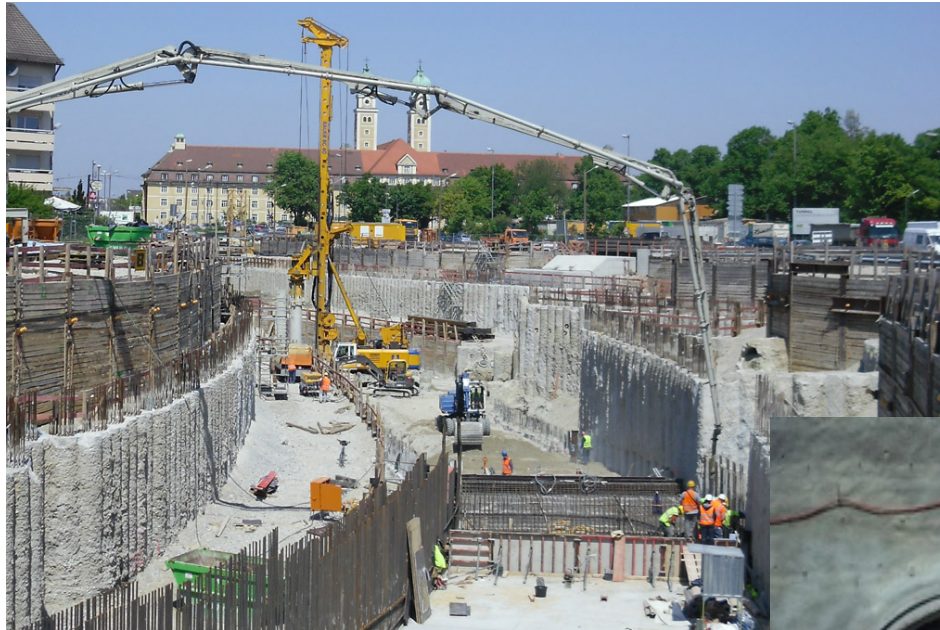
Baustelle offener Tunnel 1 Röhre 2-streifig
