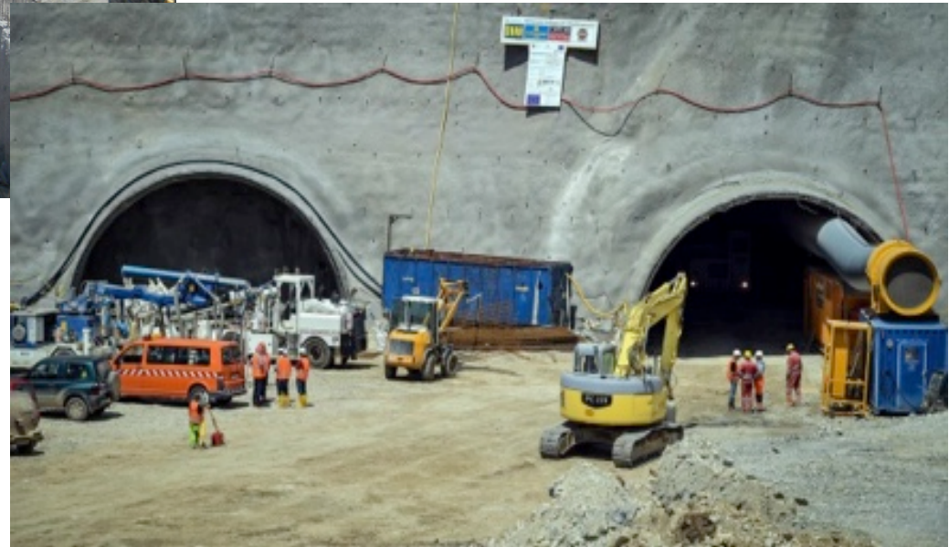
Baustelle Gebohrter Tunnel 2 Röhren 4-streifig
