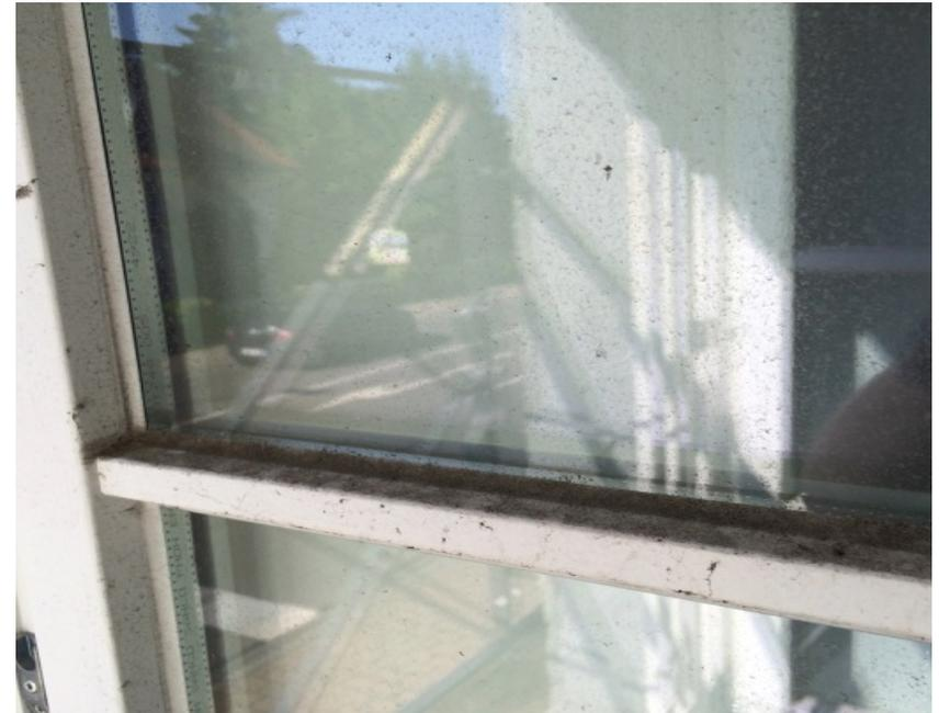
**Bild:** Schmutzablagerung auf Fenster an der B31 in Hagnau innerhalb von 3 Monaten (VIHaB e.V.)
